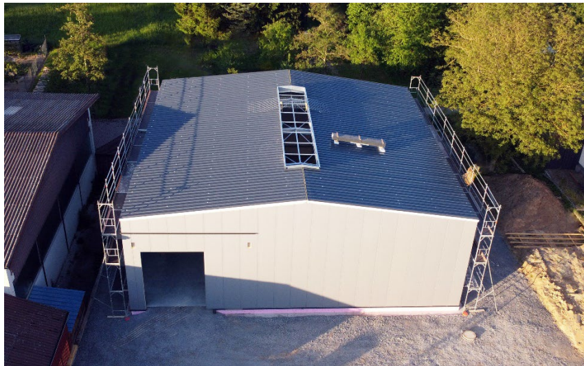
Mehr Raum für die wachsende Digitalisierung der Energie- und Gebäudetechnik © PGA Automation
